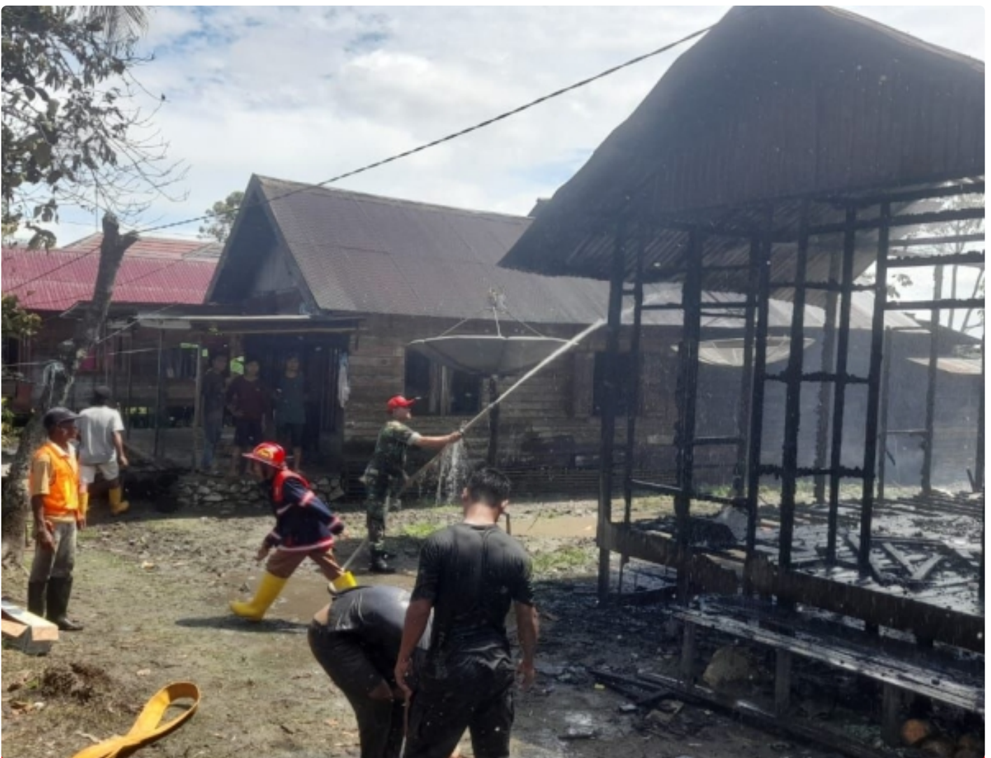
Sigap Anggota Koramil 05/Pandawan Bantu Padamkan Kebakaran Rumah Warga
